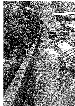
INICIO DEL LEVANTADO DE PARED, CIRCULACIÓN PERIMETRAL.
