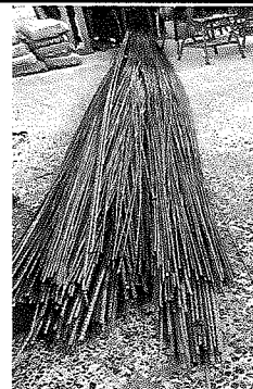
HIERRO UTILIZADO PARA CONSTRUCCIÓN DE MURO PERIMETRAL.
