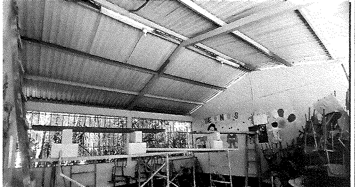
AVANCES DEL TRABAJO DE MANTENIMIENTO A LA ESTRUCTURA METÁLICA.
