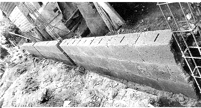
CONSTRUCCIÓN DE MURO PERIMETRAL.
